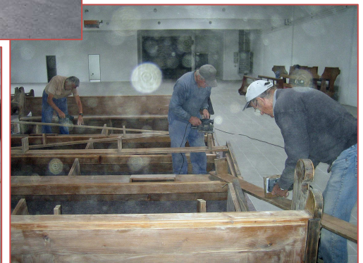
September 2010: Die ausgelagerten Kirchenbänke werden geschliffen und neu lackiert
