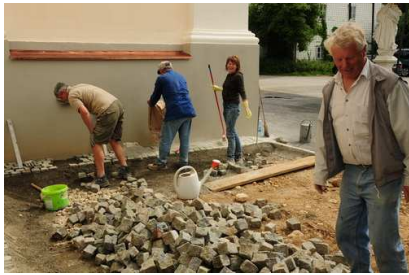
19. August 2010: Granitpflasterung entlang des Turmes
