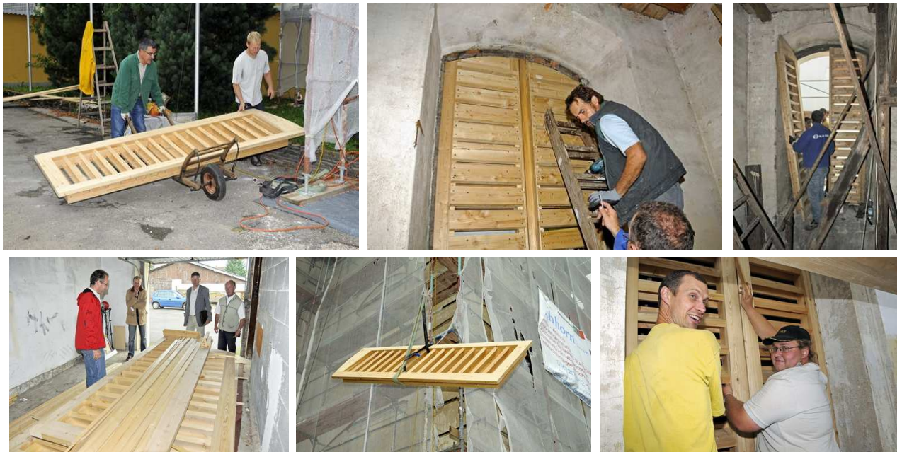
22. August 2009: Holzjalousien im Turm werden erneuert
