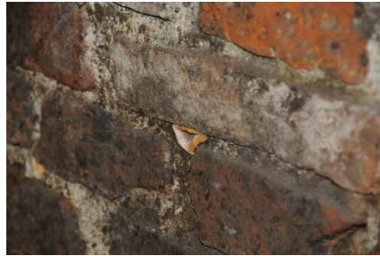
3. September 2010: Mauerschwamm tritt auf und muss bekämpft werden
