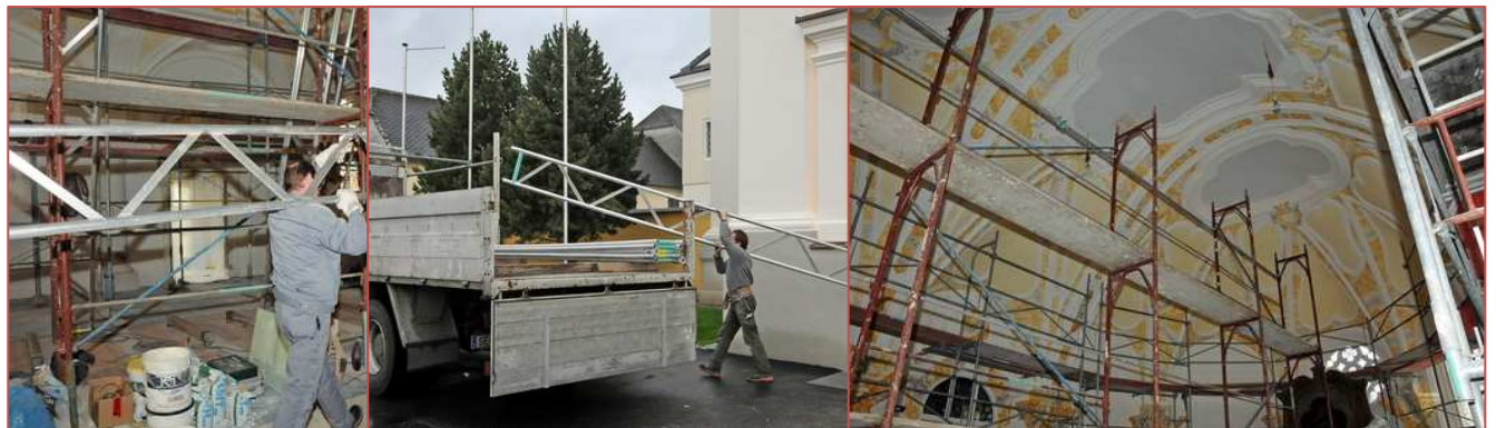
25. November 2010: Abbau des Gerüsts, die neue Raumschale wird sichtbar
