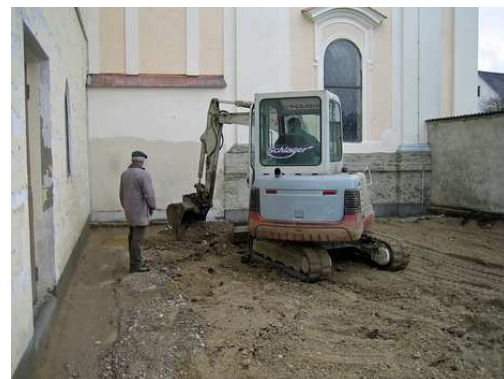
18. November 2009: Fundamente im Außenbereich müssen „trockengelegt“ werden
