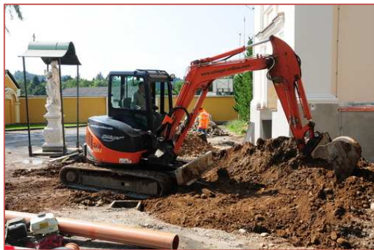
Juli 2010: Teilerneuerung der Kanalisation und der Wasserleitung
