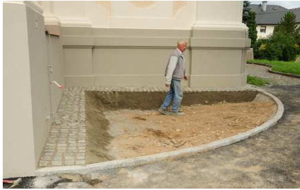
19. August 2010: Granitpflasterung entlang des Turmes
