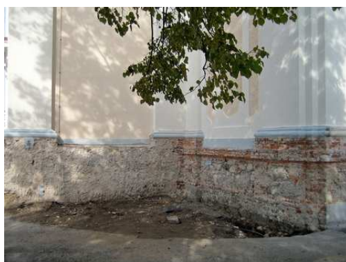
18. November 2009: Fundamente im Außenbereich müssen „trockengelegt“ werden
